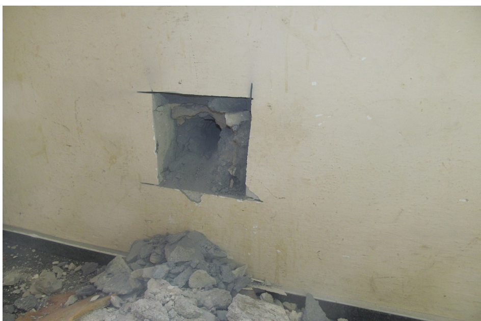
Sonda do parapetního zdiva. Plynosilikátové tvárnice zděné na vápenno cementovou maltu.
