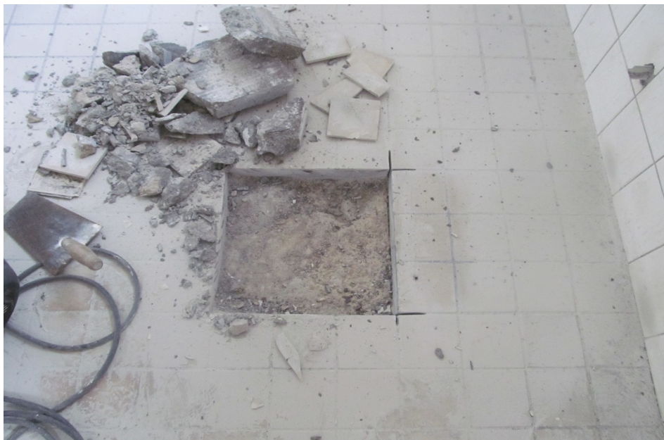
Sonda do konstrukce stropu nad 1NP v místě kuchyně.
