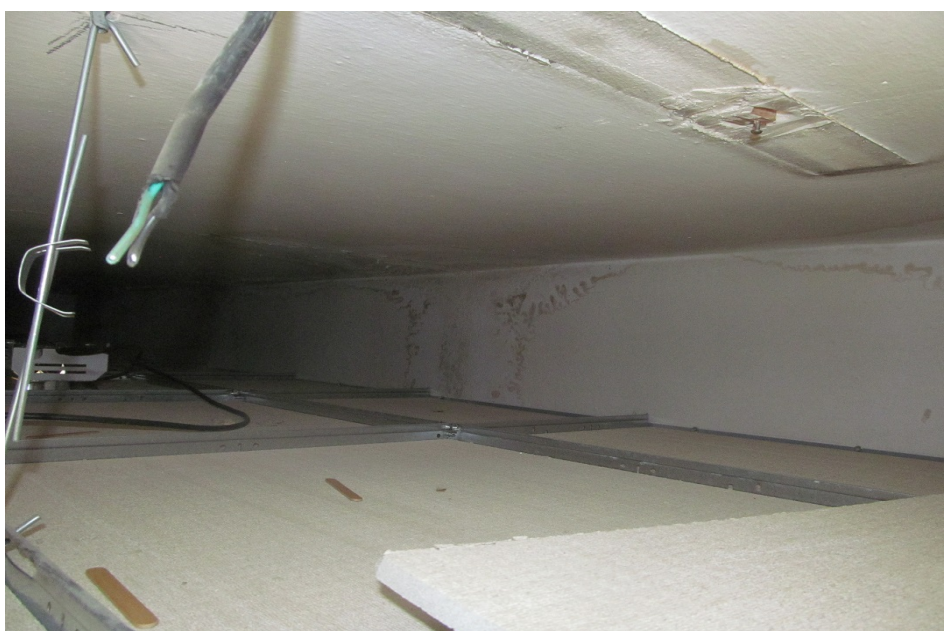
Sonda do podhledu stropu v 2.NP. Zavěšený podhled z minerálních dílců. Na stěně je možno vidět zátoky, další důkaz o dožilosti střechy jako celku
