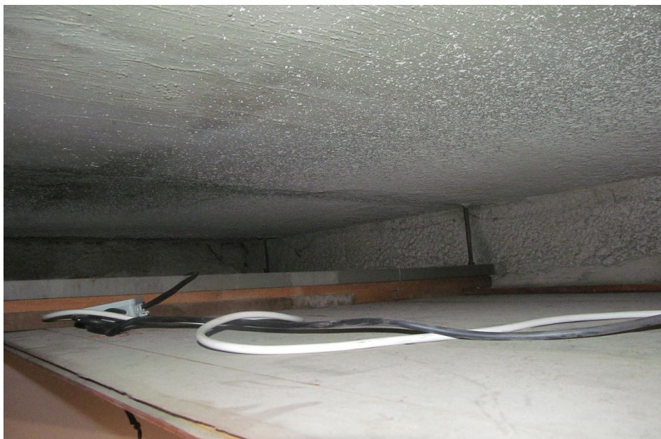
Sonda do konstrukce podhledu v 1NP. V mezeře mezi panely je táhlo vyvěšující ocelový nosník U 80, na který ke kotvena lať a k ní přibity dřevěné palubky.
